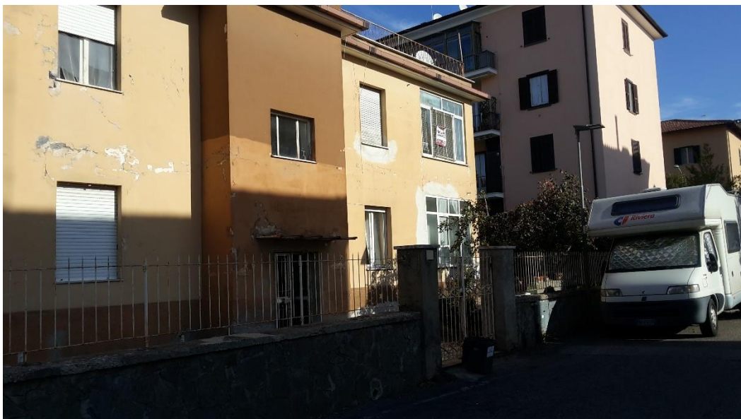
FOTO 1 – ingresso su Via Postumia
